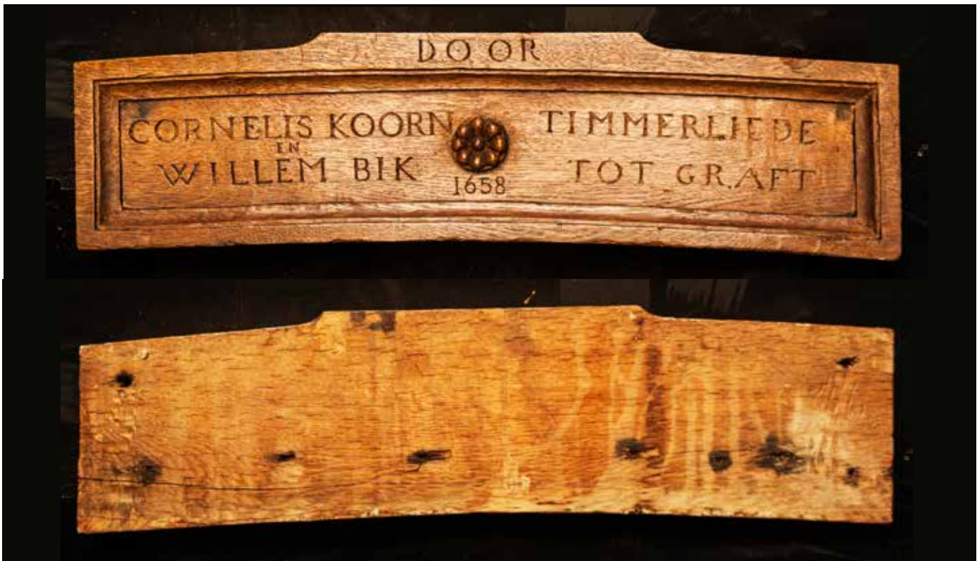
De eikenhouten balk uit de voormalige Bonifatiuskerk in Graft. Met als tekst: 'DOOR CORNELIS KOORN EN WILLEM BIK TIMMERLIEDE TOT GRAFT. 1658', 52,5 x 13 x 5,5 cm. De achterkant van de balk. Bovenin de gaten van de bouten waarmee de balk was vastgezet.
