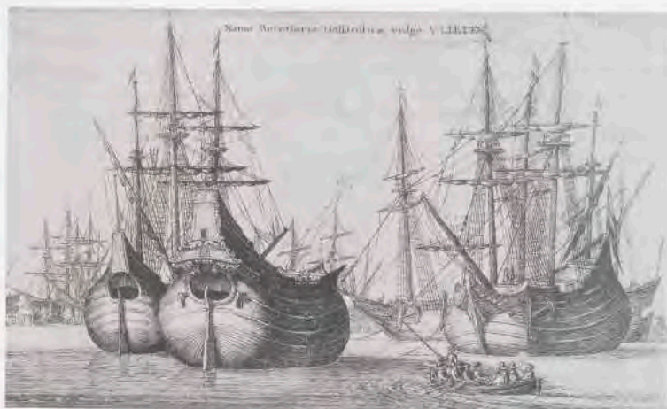
Abb. 1. Hollandse fluitschepen. Ets door W. Hollar, 1647, Collectie van de stichting Atlas van Stolk, Rotterdam. De Oostzeehandel werd grotendeels gevoerd met behulp van fluiten, een scheepstype dat speciale geschikt was voor het vervoer van zware bulkgoederen.
