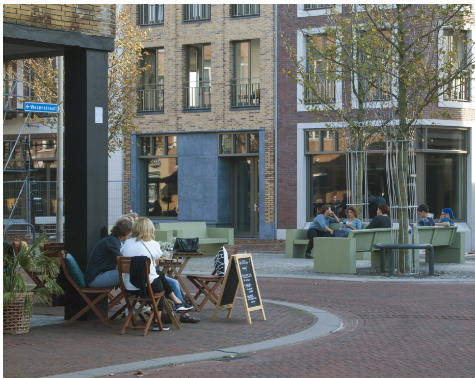
Nieuwbouw aan de Beatrixstraat. Fotografie: Kris Oosting
