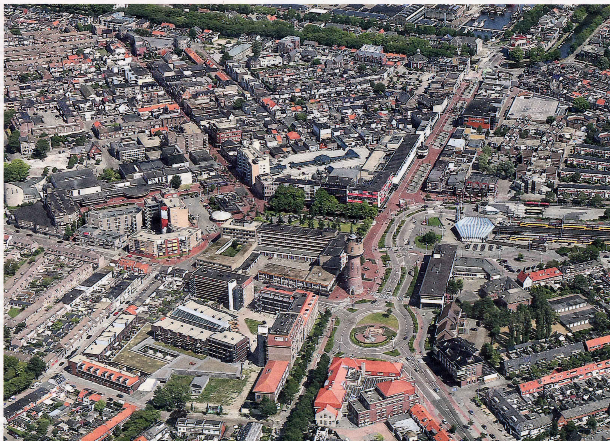
De huidige situatie in het stadshart. De flink uitgebreide schouwburg is links van het midden te zien. Zoek de verschillen met de foto hier onder.
