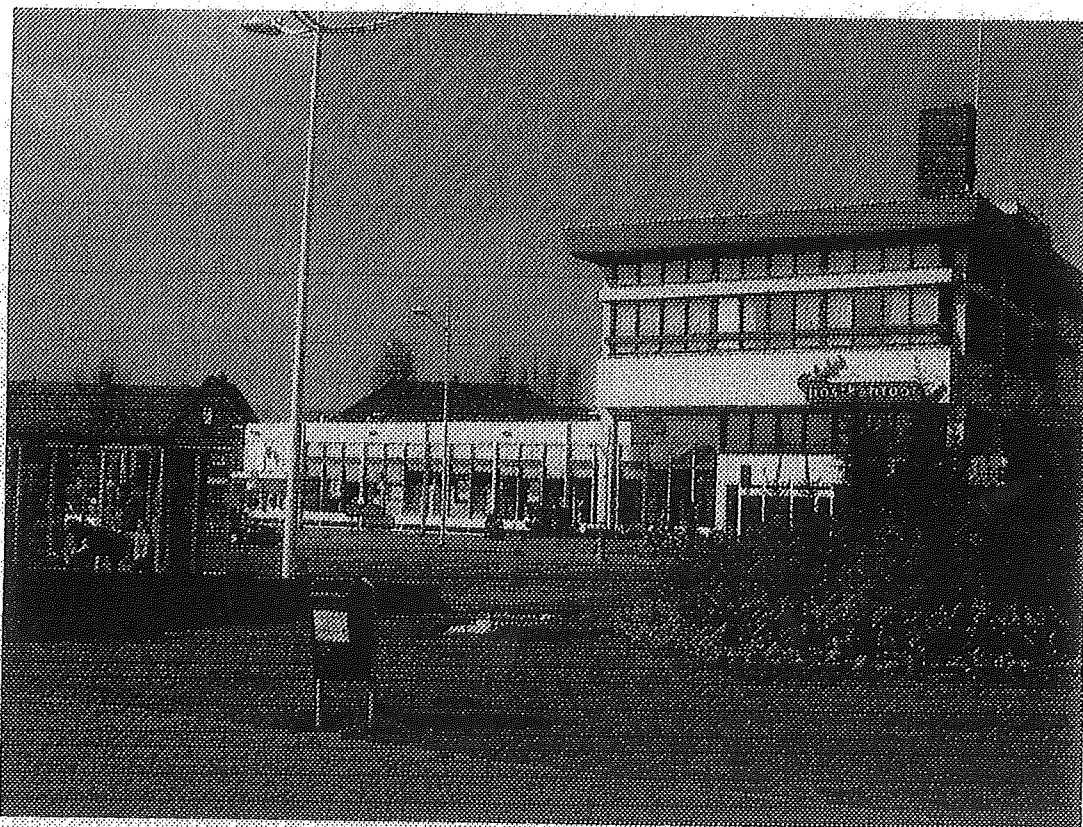
Foto voorgevel vm. postkantoor Middenweg 174 te Den Helder.
